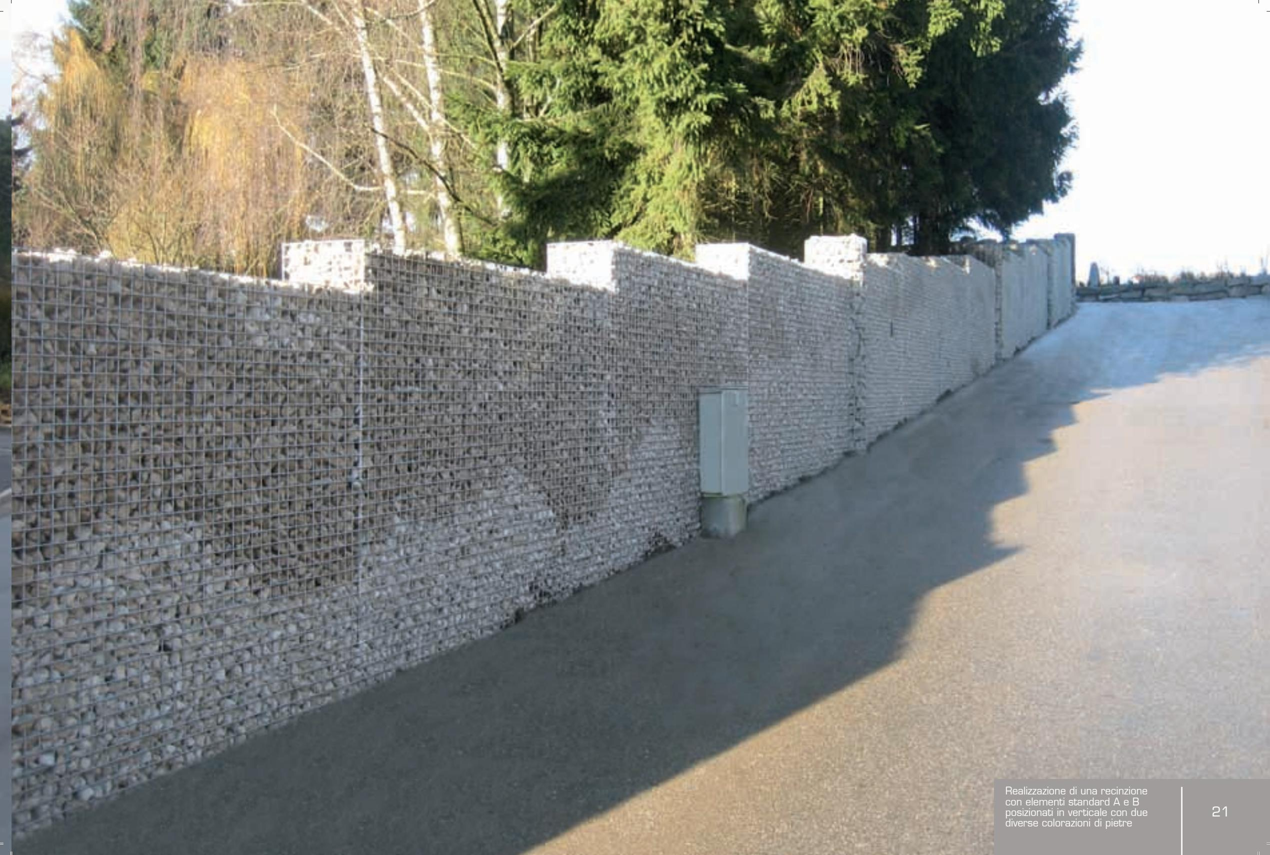
Realizzazione di una recinzione con elementi standard A e B posizionati in verticale con due diverse colorazioni di pietre
